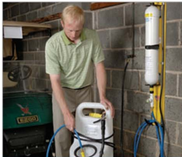
System dejonizera używany do napełniania wózka transportowego Hydrofill
